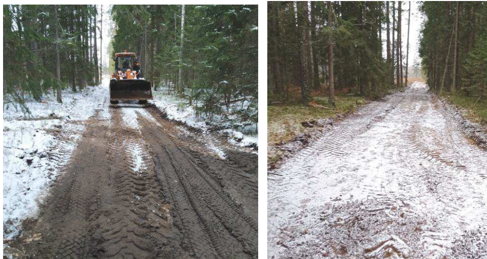
Рисунок 5 – Формирование корытообразного профиля на объекте 2
