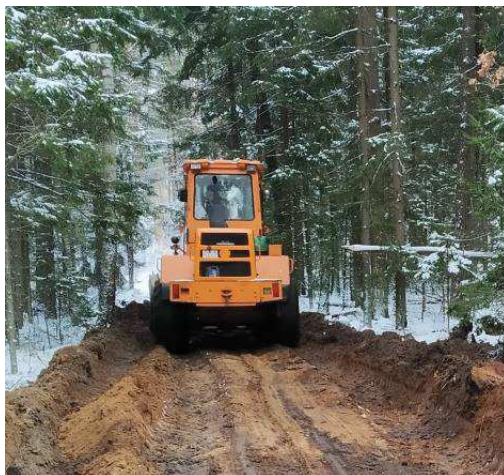
Рисунок 4 – Формирование корытообразного профиля на объекте 1
