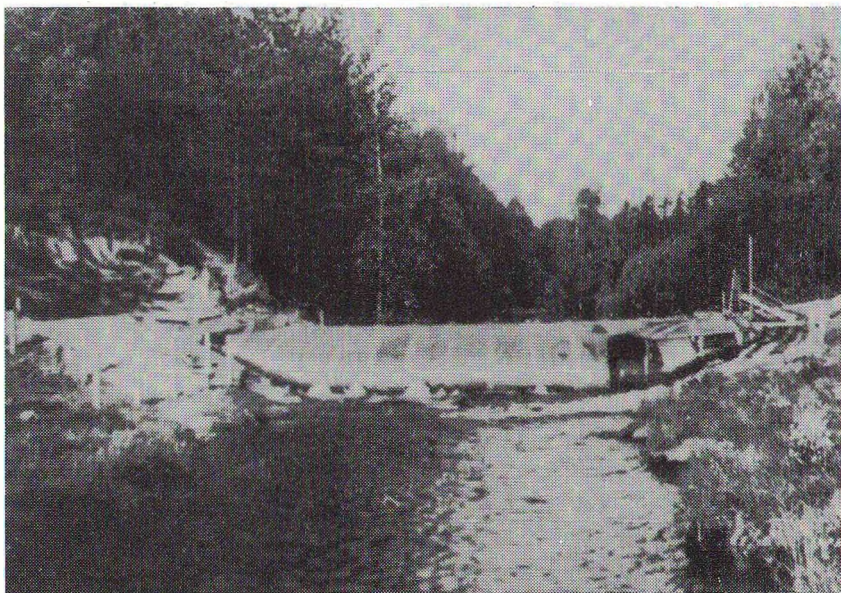
Рис. 1. Вид на плотину со стороны нижнего бьефа.
