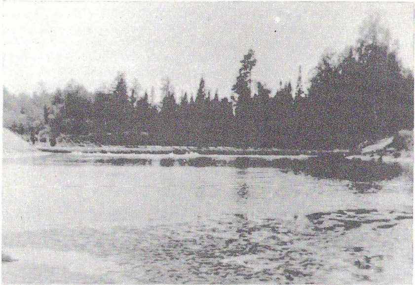
Рис. 3. Плотина ПЗТ-50/2 БС в расчетном створе на реке Лолог.
