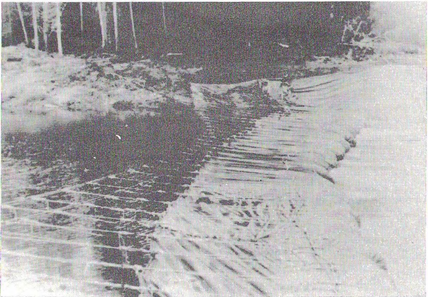
Рис. 4. Деформация плотины при наполнении.
