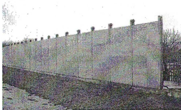
Рис. 1. Шумозащитный экран из деревянных досок
