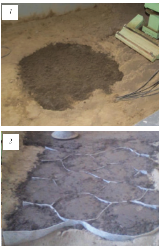
Рис. 2. Модельные участки дорожных конструкций в грунтовом канале: 1 – дорожная конструкция из цементогрунта; 2 – дорожная конструкция из арматурного каркаса
