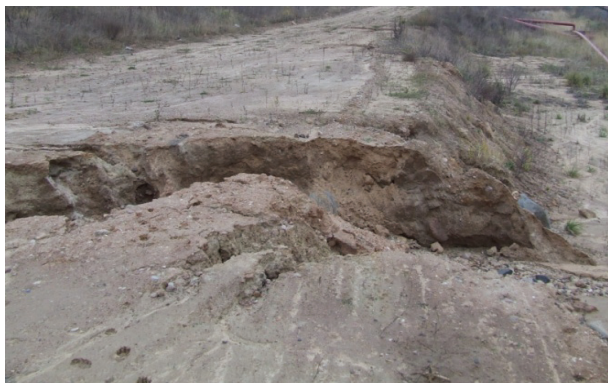
Рис. 1. Повреждения низовых откосов ограждающих сооружений шламохранилищ
