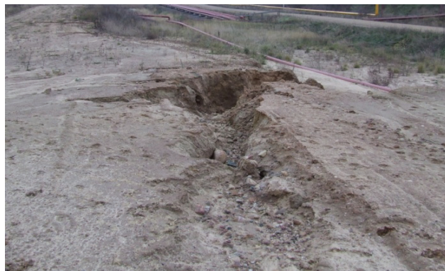
Рис. 1. Повреждения низовых откосов ограждающих сооружений шламохранилищ
