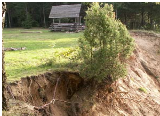
Рис. 7. Разрушение берегов Вилейского водохранилища
