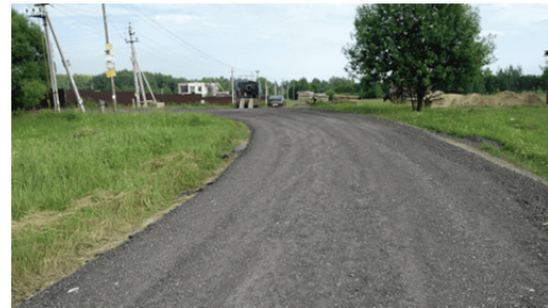
Рис. 5. Внутрихозяйственная дорога с покрытием из асфальтогранулята
