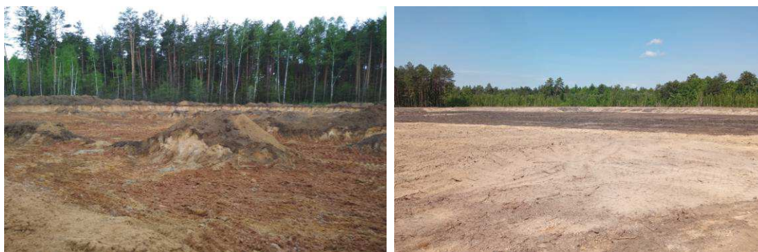
Рисунок 3 – Разработка внутрихозяйственного карьера
