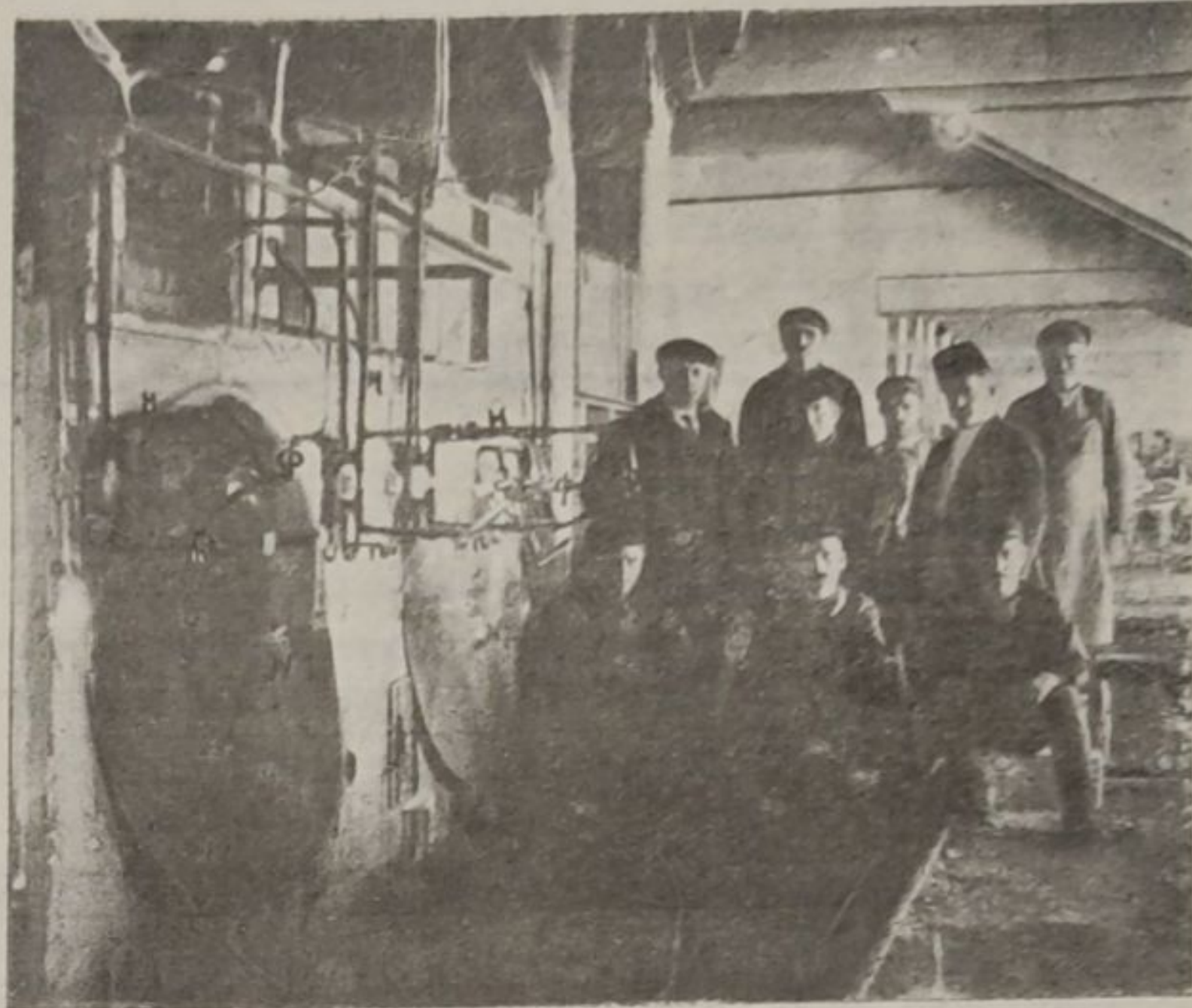
Рис. 1. Топки туннельного горна для жидкого топлива. ф—форсунки, н—нефтепровод, п—паропровод.
