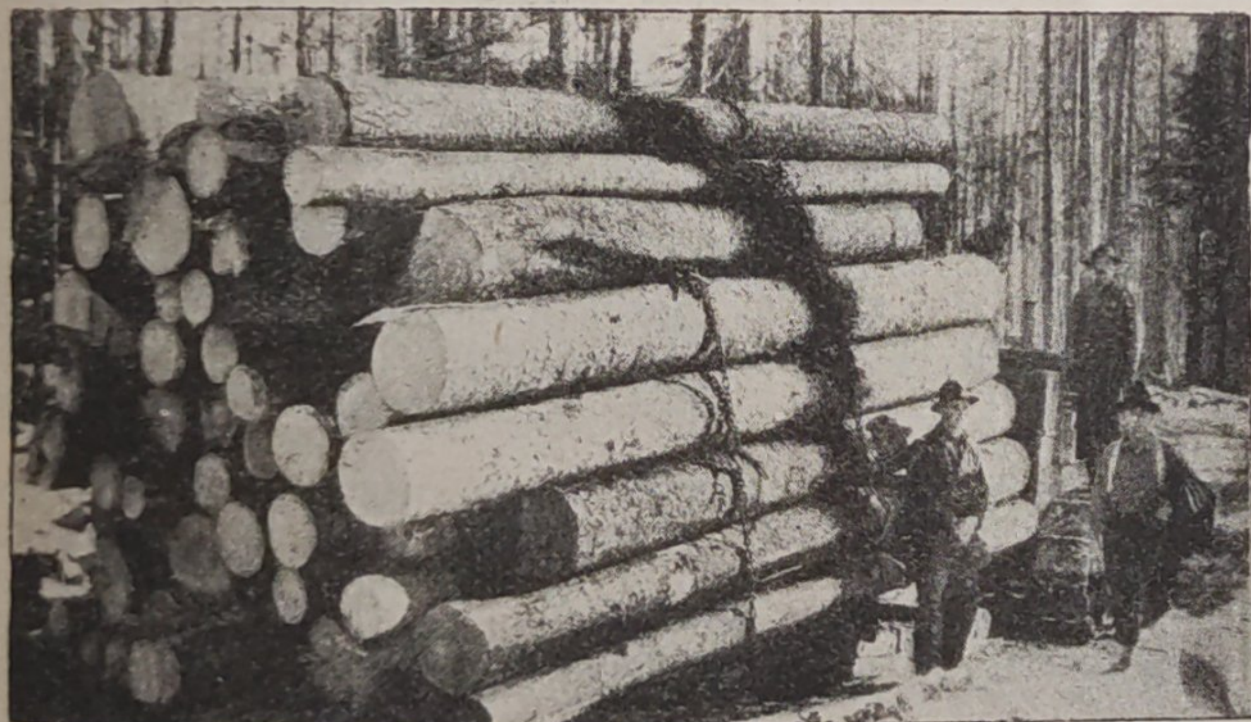
Рис. 2. Груз 10-тонного трактора. Заметить: 2 цепи, охватывающие груз.
