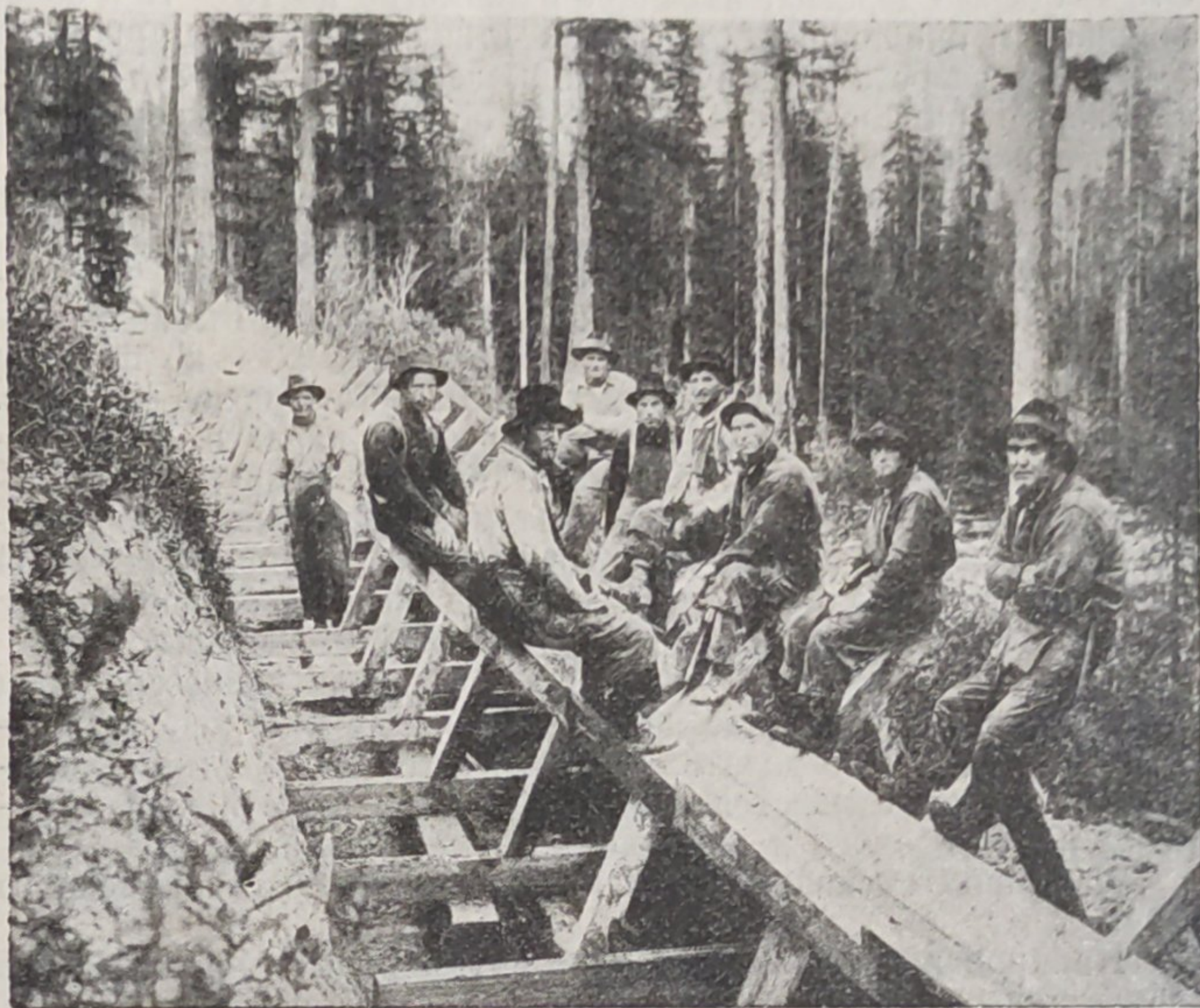
Рис. 7. Конструкция лотка.
