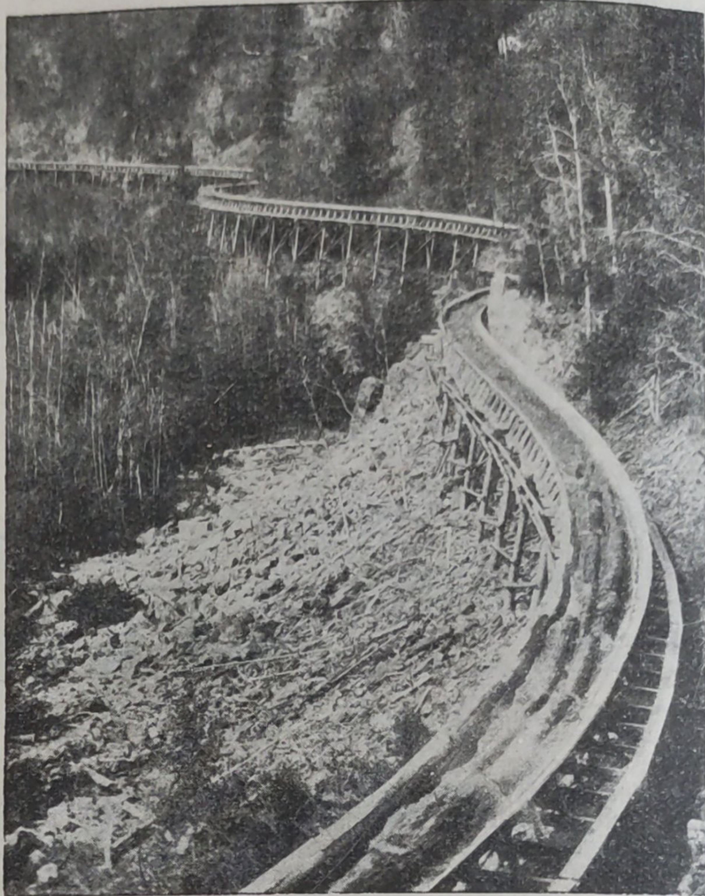
Рис. 5. Лоток. Видны сложные закругления.
