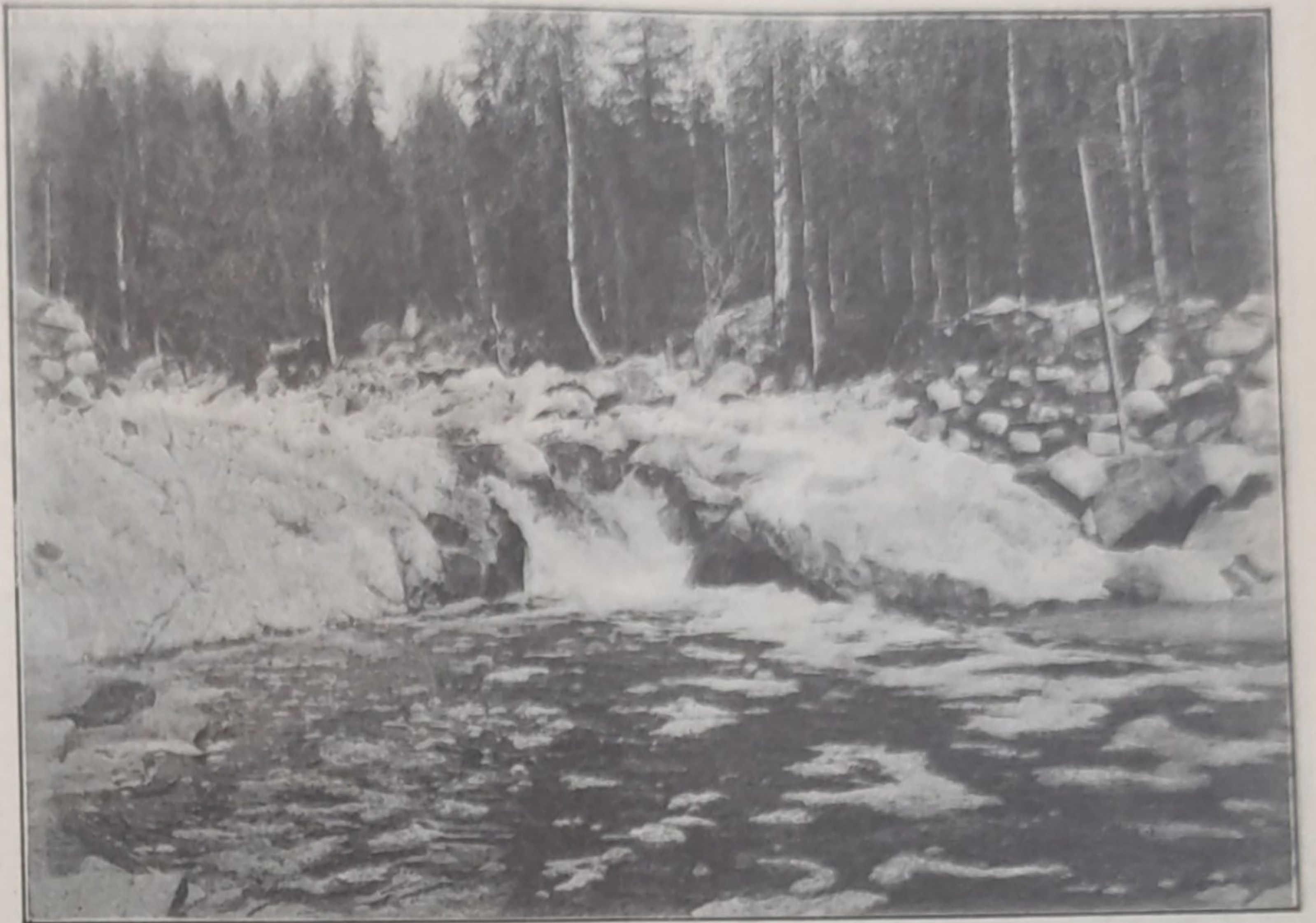
Рис. 3. Плотина на р. Колась, разобранная для прохода льда.
