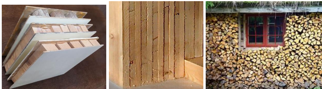
Рисунок 1 – Примеры использования ретродревесины: торцовой шашки в среднем слое, досок в строительных панелях МНМ «чуркобетона» в стене
