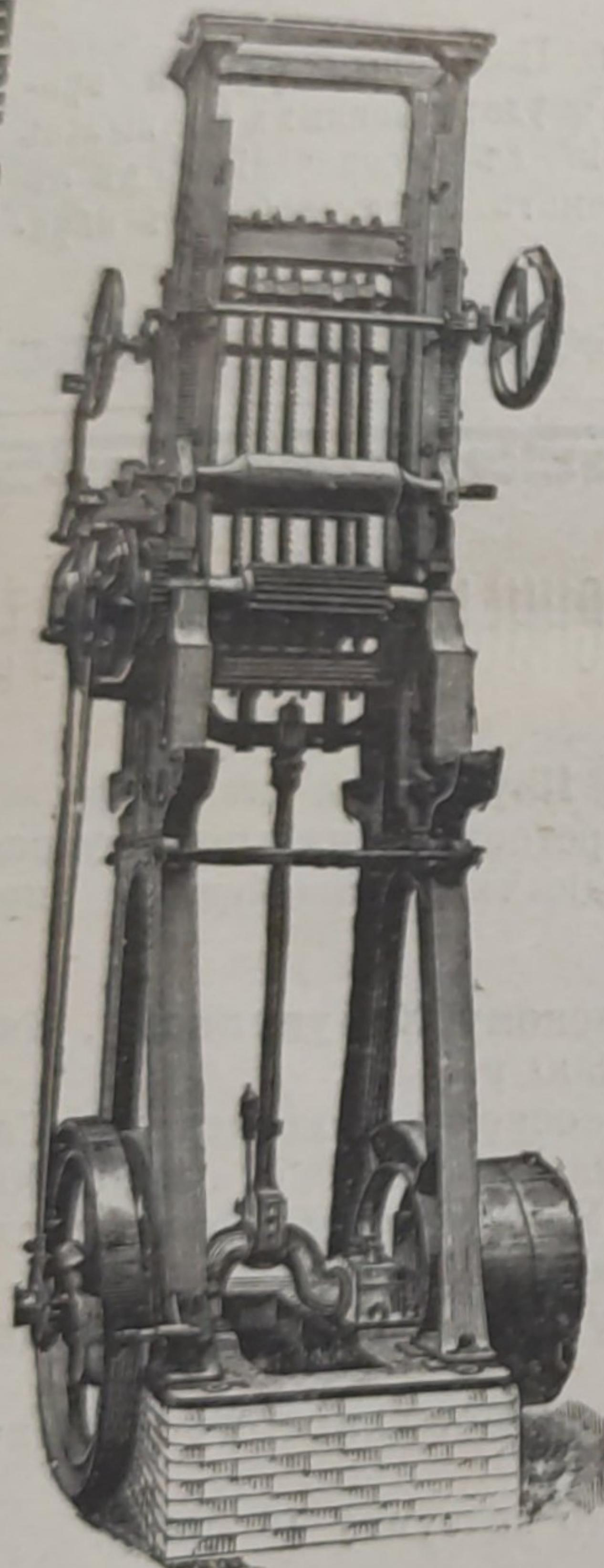
Строгальные станки новѣйшей конструкціи и недостигнутой еще по сіе время производительности изготавляются въ болѣе чѣмъ 30 величинъ. Съ нашимъ строгальнымъ станкомъ № 12 была достигнута производительность въ 100000 футъ или 43000 аршинъ гребня и паза въ теченіе 10 час.
