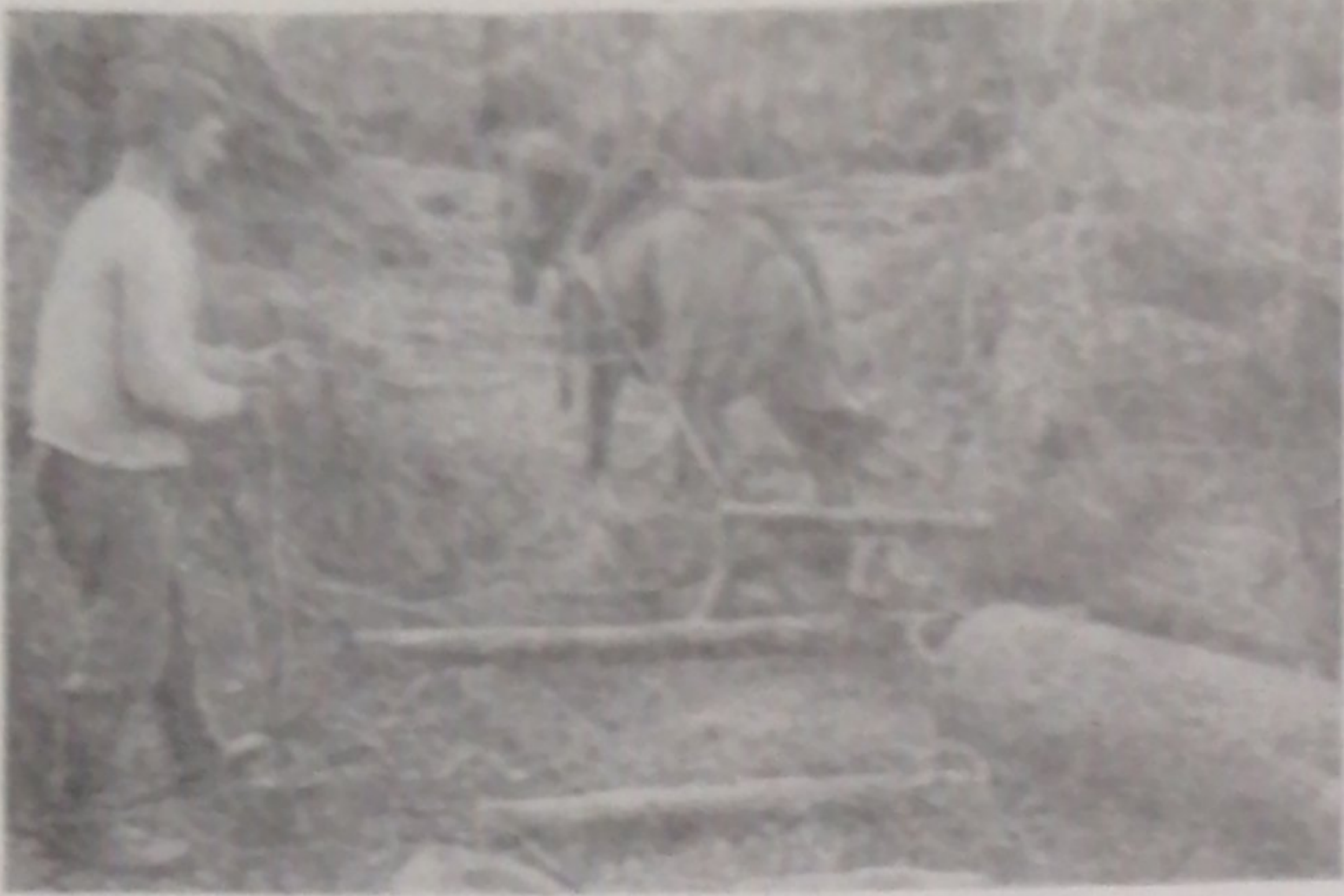
Рис. 10. Трелевка клещами
