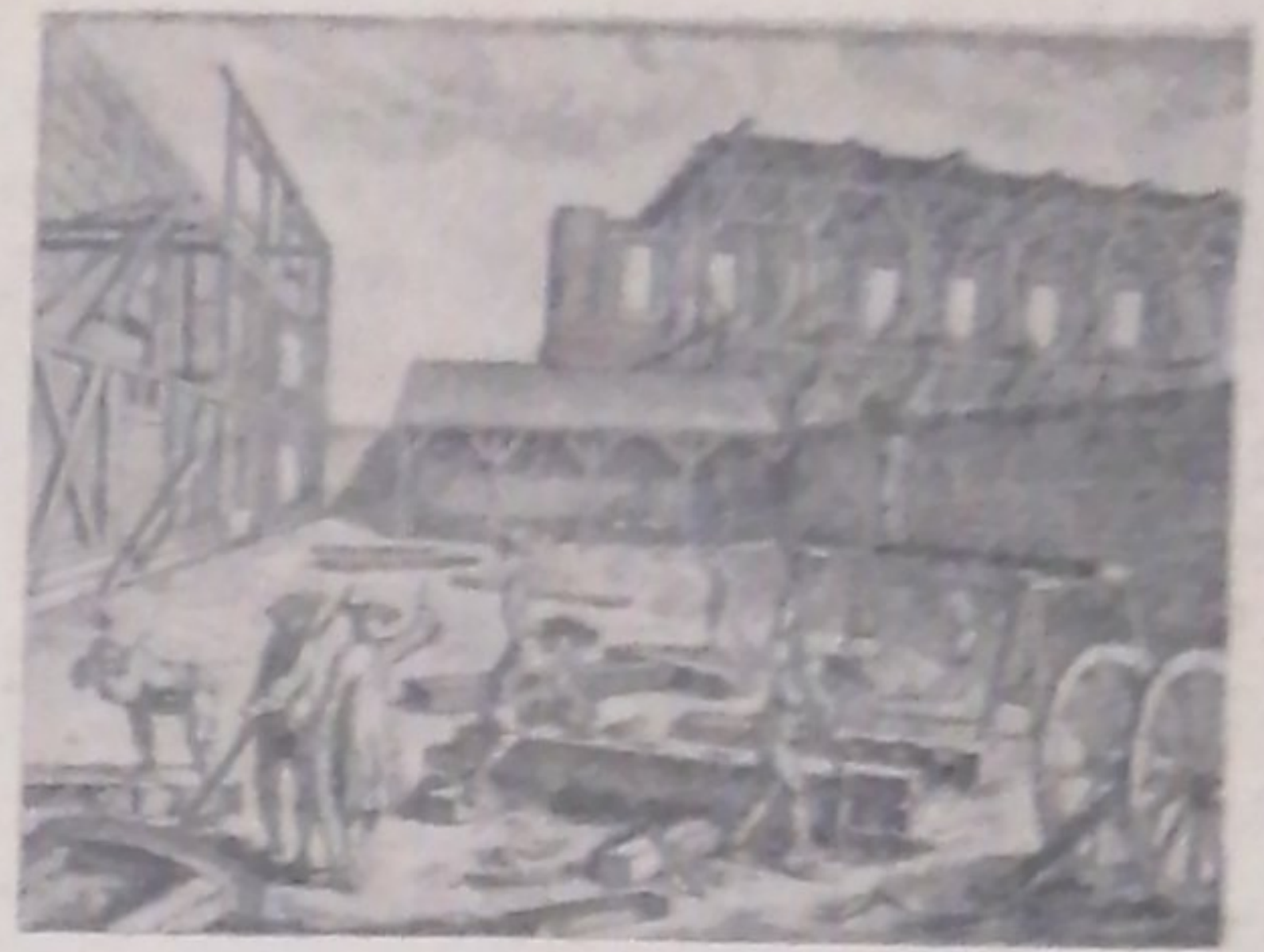
3. Плотничные работы по принципу мануфактурного разделения труда (Франция, 1763 г.). Каждый выполняет свою частичную операцию, представляющую определенную функцию «общественного собирательного рабочего»
