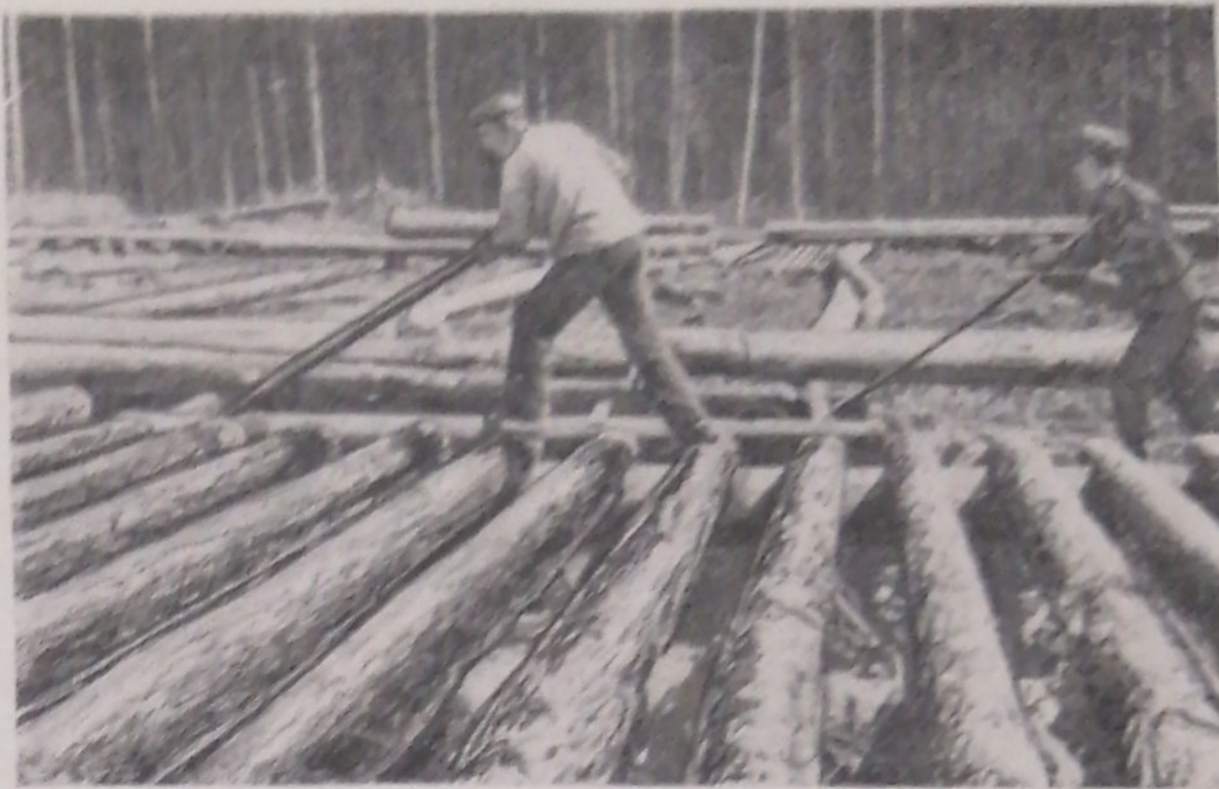
Рис. 8. Износ эстакады через 3 мес. работы одного трактора
