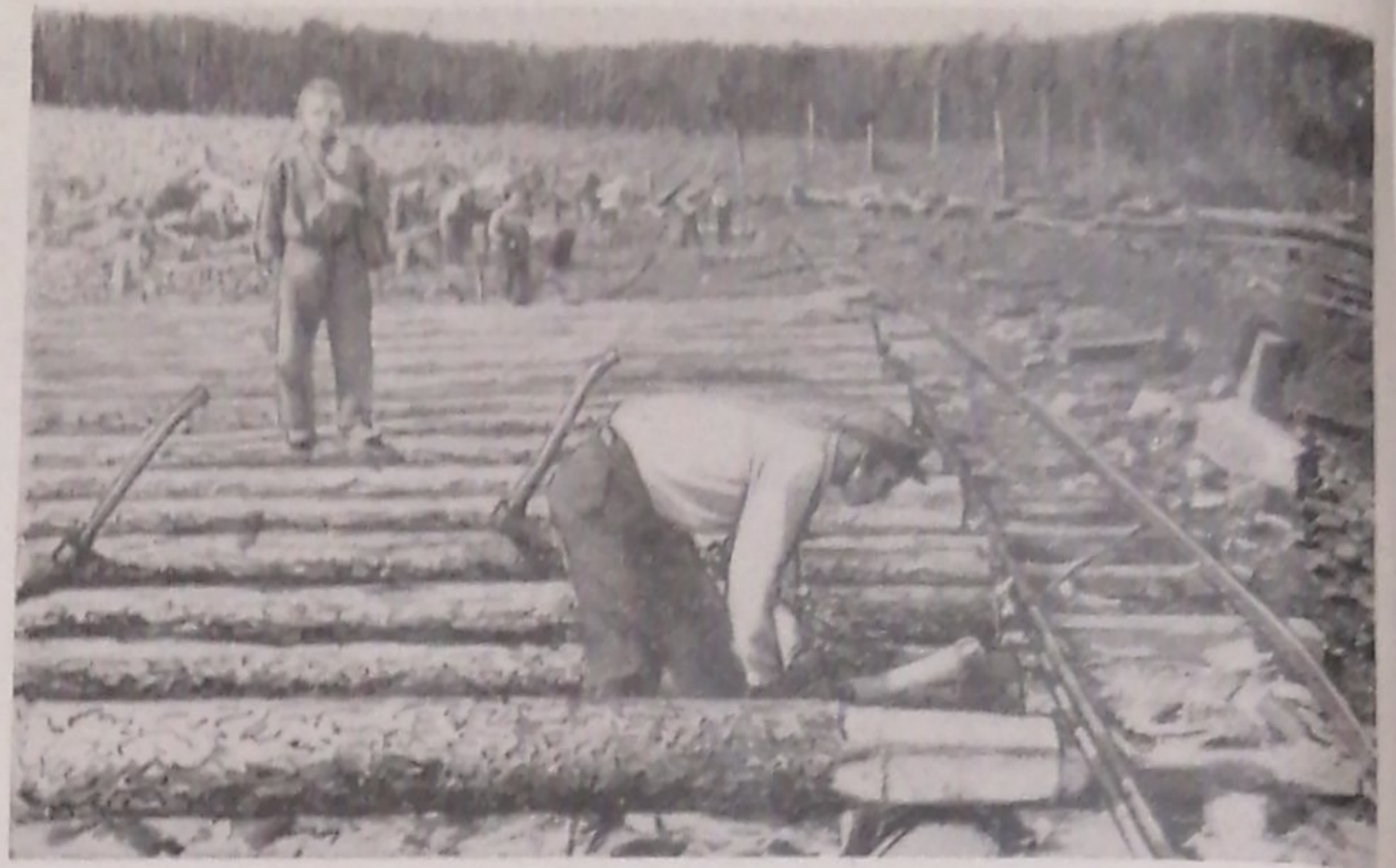
Рис. 4. Строительство новой эстакады. Впереди — бревно окантовано в месте соединения с лежнем
