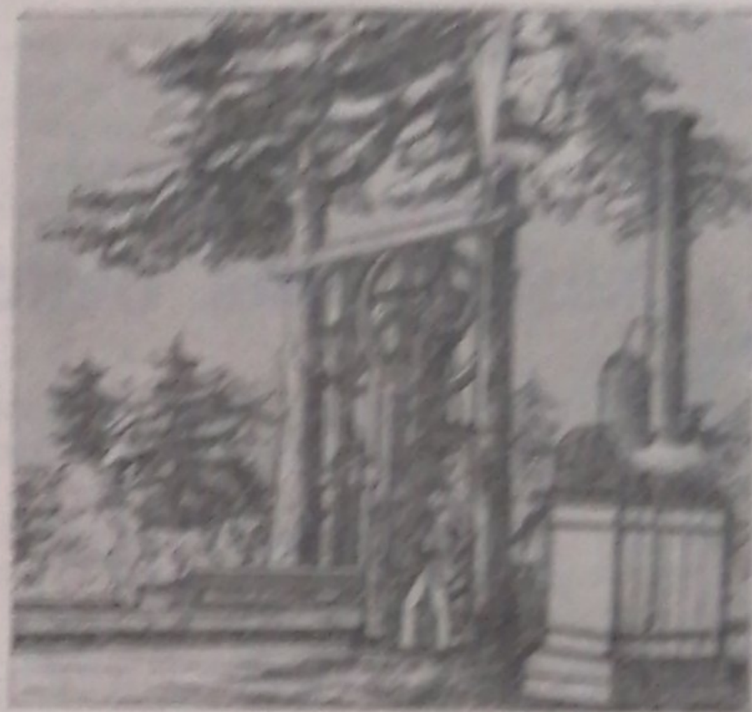
Рис. 5. Паровая переносная лесопильная установка, сконструированная инженером Лидвиком Чешко. Пильная рама укреплялась между деревьями. Конструкция усовершенствовалась на выставке в Венеции 1874 г.
