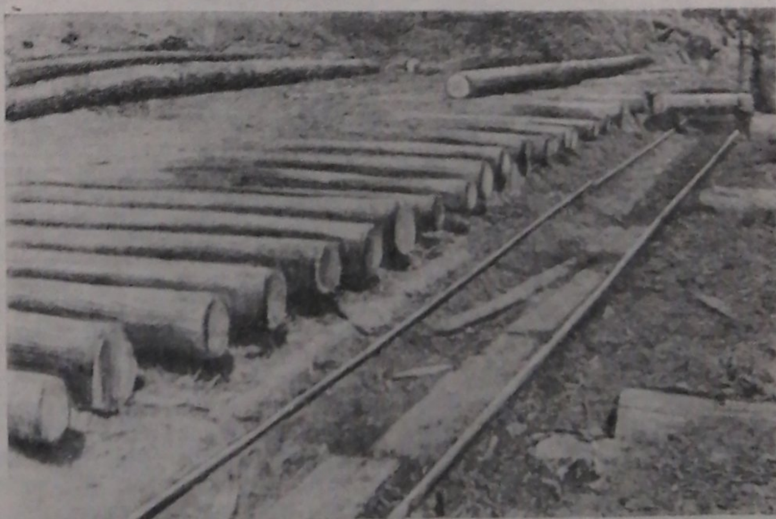
Рис. 9. Общий вид эстакады, работающей второе лето
