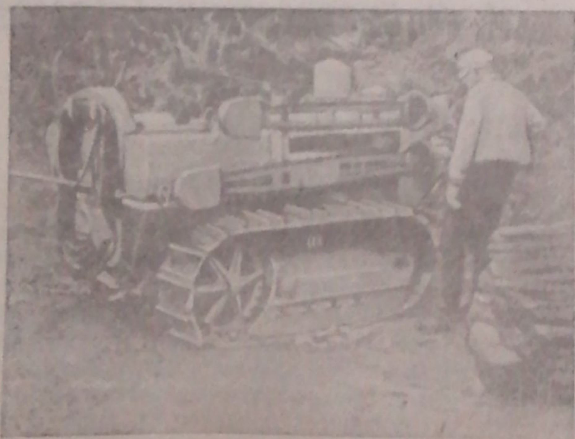
Рис. 1. Электростанция, смонтированная на тракторе Катерпиллер
