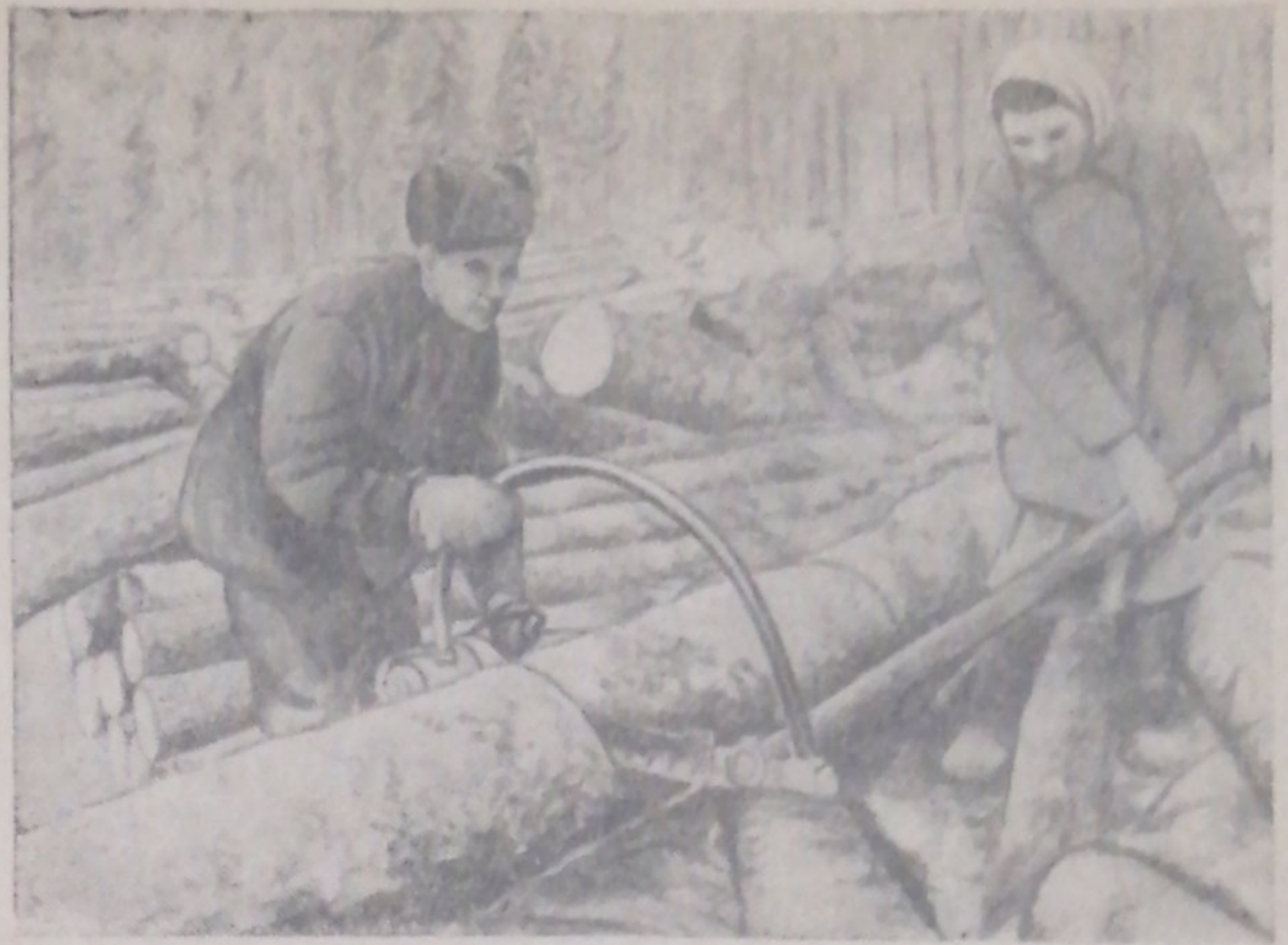
Рис. 4. Электропила конструкции Харламова на разделке
