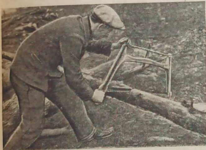
Рис. 7. Лучок карельского типа. Рука лесоруба находится ниже полотна пилы
