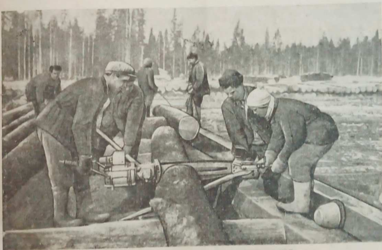
Рис. 1. Электромоторная цепная пила СевНИИЭЛП типа ПЭП-1
