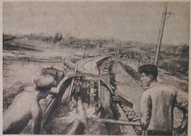
Рис. 3. Транспортёр-выбрасыватель в работе
