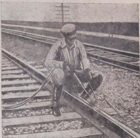
Рис. 1. Электронаплавка стыка
