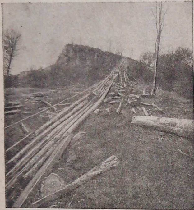
Рис. 5. Общий вид механизированного лотоспуска Даховского участка
