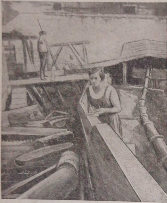
Рис. 1. Перевалочный бункер элеватора и трубопровод к приемнику транспортера
