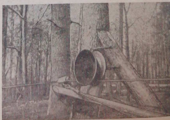
Рис. 12. Замок чокера проходит поддерживающий и направляющий ролики
