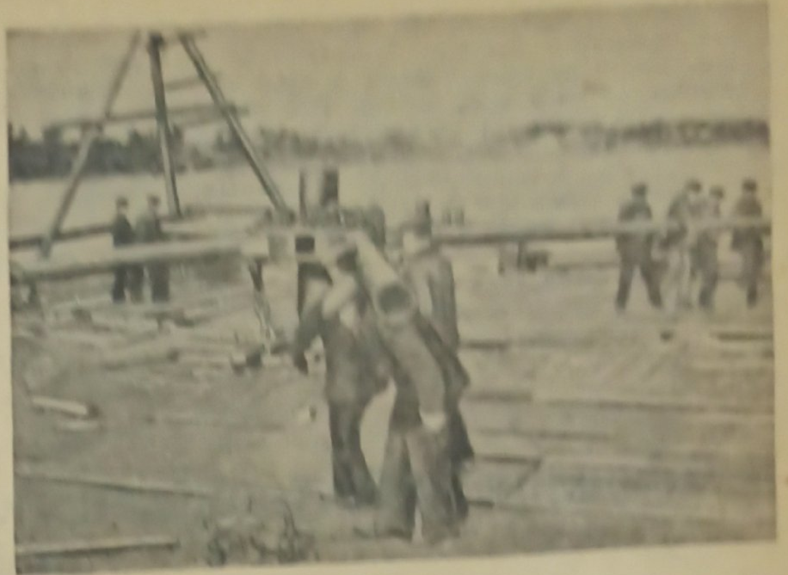
Рис. 5. Ручное завинчивание аншпугами
