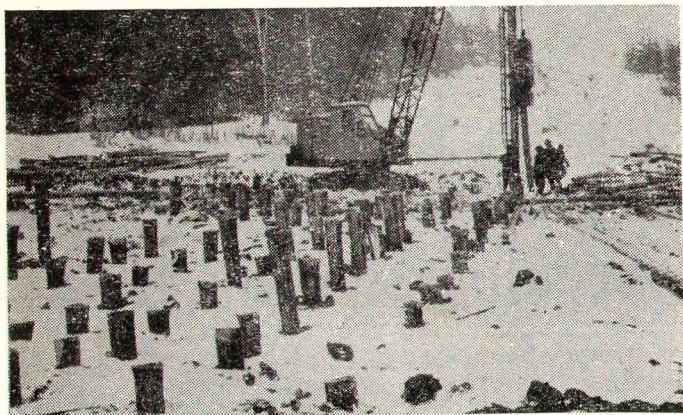
Рис. 30. Подготовка свайного основания
