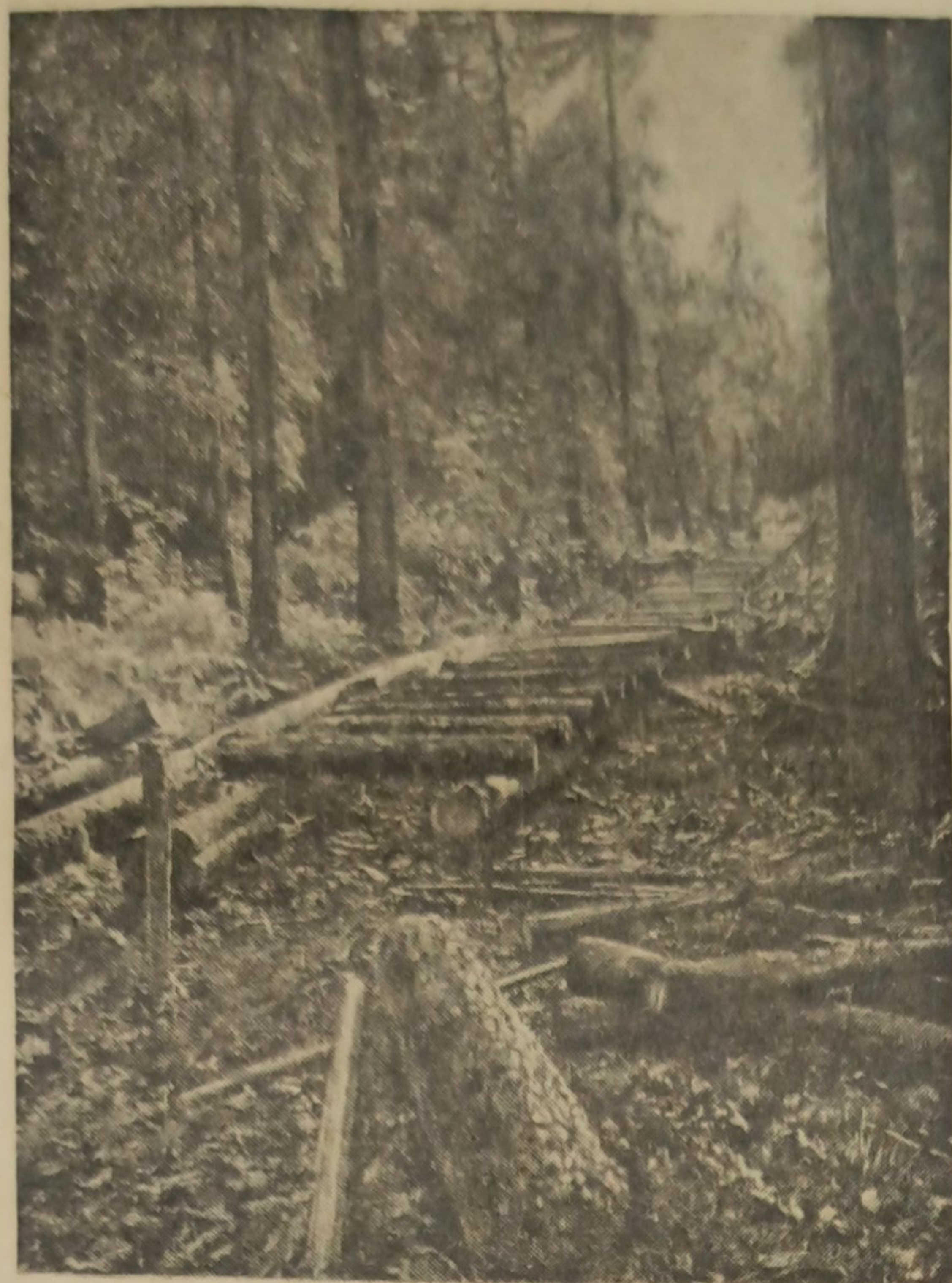
Рис. 3. Укладка круглых шпал на продольные лаги
