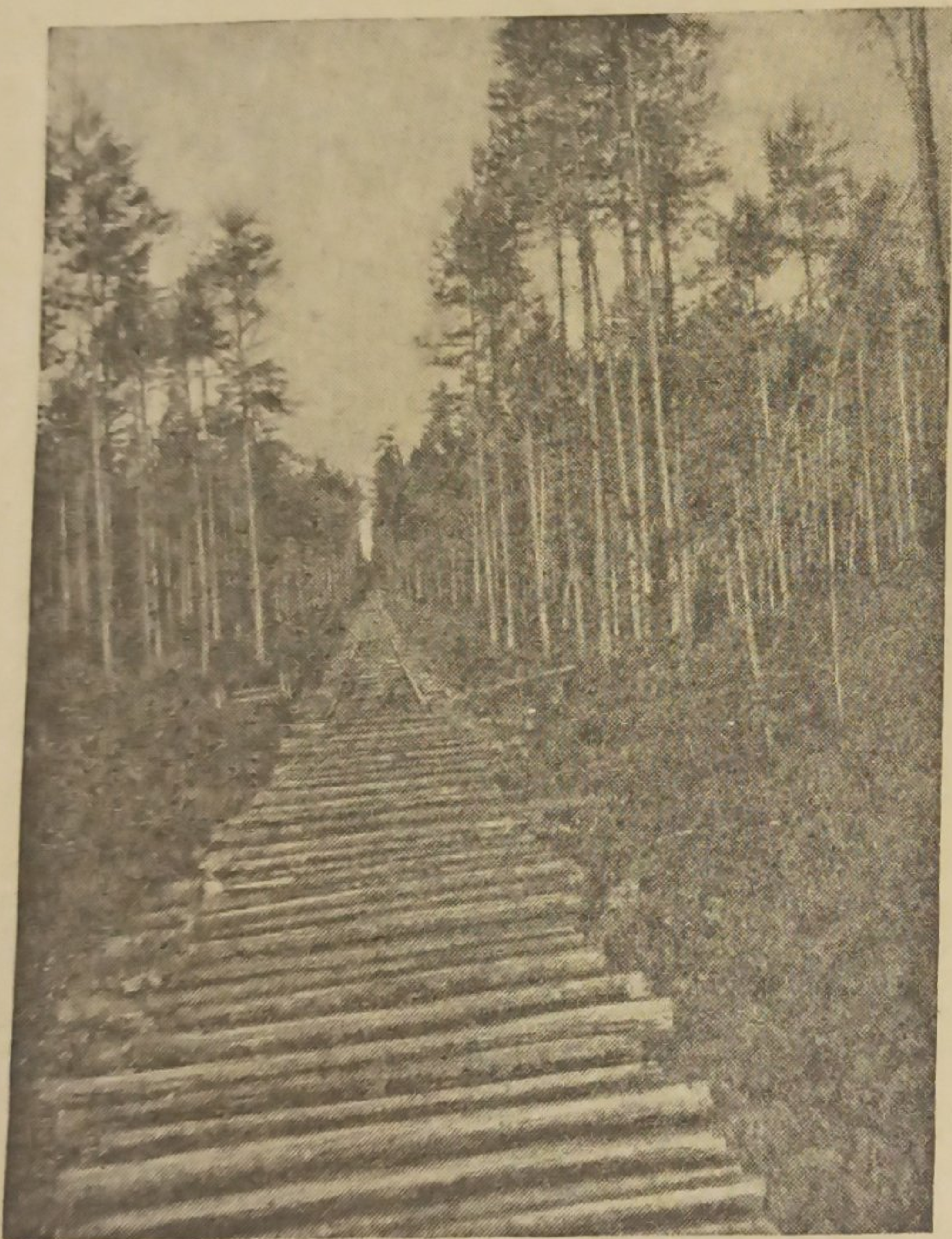
Рис. 5. Поперечный ступняк перед укладкой рельсов
