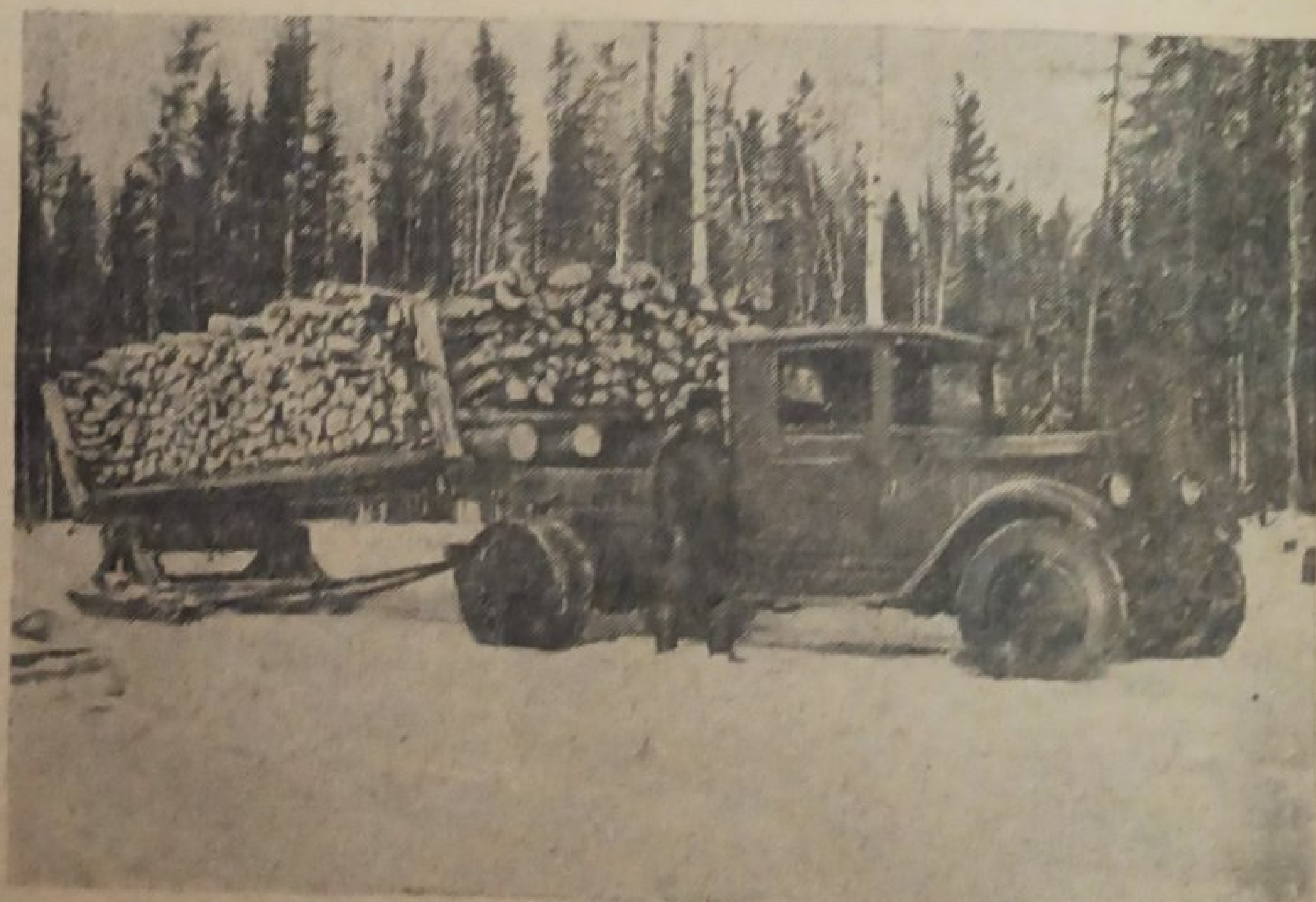
Рис. 2. Вывозка дров-коротья с санным полуприцепом без специальной рамы (нагрузка 17 скл. м 3 )
