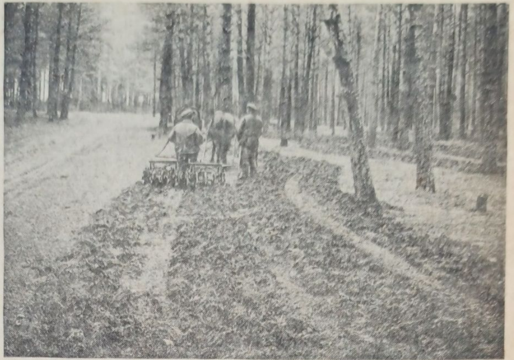
Рис. 2. Дисково-зубчатая борона ДЗК-10
