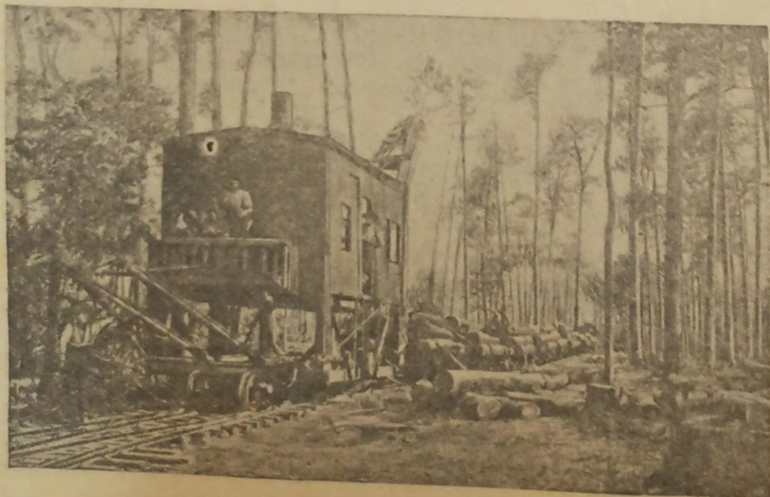
Рис. 1. Американский кран «Деккер» после окончания погрузки состава. Готов для передвижения на новое место
