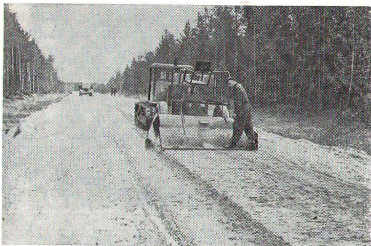
Рис. 7. Рыхление грунта на проезжей части дороги.
