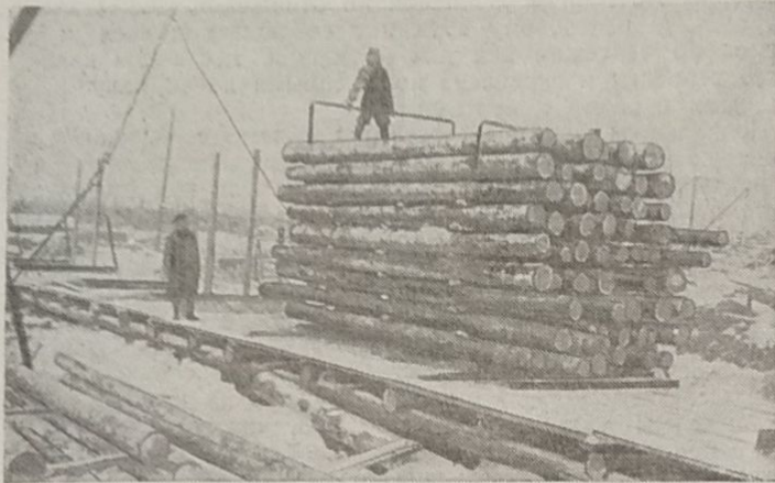
Рис. 4. Пакет закончен, сформирован и на него сверху укладывается вторая предохранительная скоба
