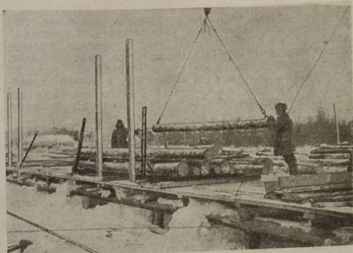
Рис. 3. Пакетный снаряд подготовлен к приему бревен; на нем укладываются первые ряды. Погрузка бревен производится конным дерриком
