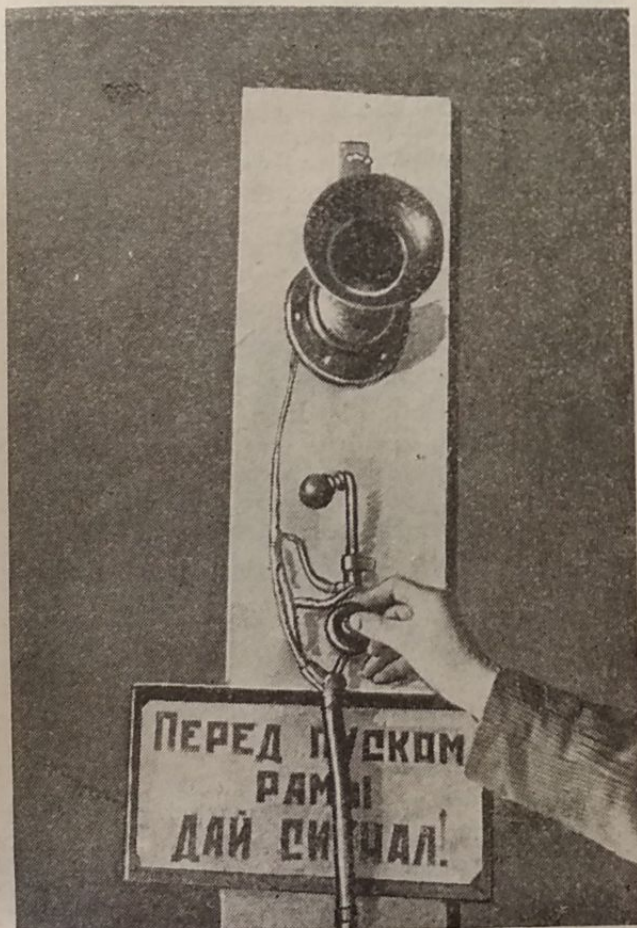
Рис. 1. Монтаж электровзвонковой сигнализационной установки
