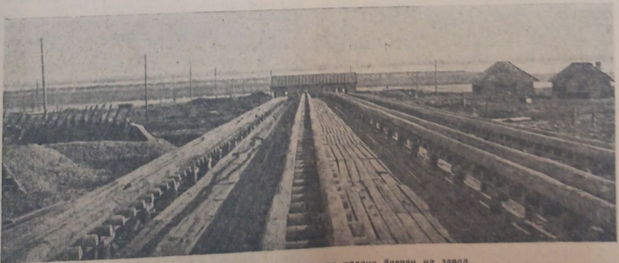
Эстакада длиной в 700 метров для подачи бревен на завод.
