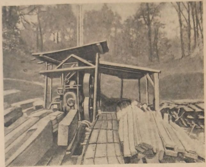
Передвижная лесопилка с газолиновым двигателем.
