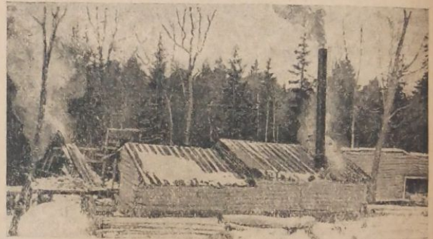
Паросиловая передвижная лесопилка тяжелого типа. Типична для передвиж. л-п заводов Нов. Шотландии (Канада)
