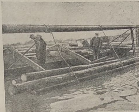
Вид на пучковязальную машину со стороны подачи древесины на элеватор
