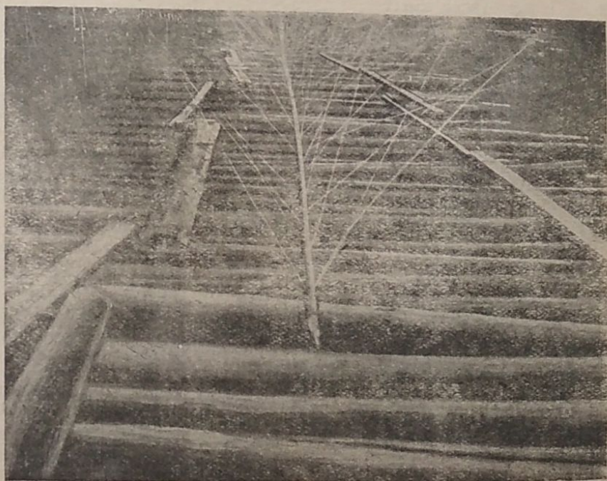
Рис. 2. Крепление дождевальных труб на тросах
