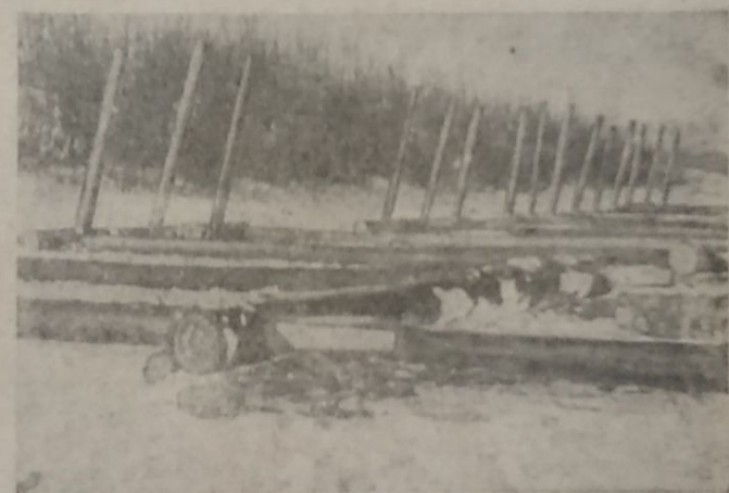
Рис. 4. Рама бабочных заделов, расположенные вдоль подъездного пути и подготовленные к загрузке их бревнами с подвижного состава
