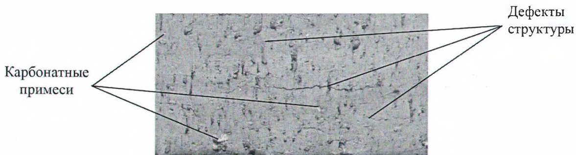
Рис. 6. Внешний вид кирпича, полученного в производственных условиях с использованием в качестве отошителя кварцевого песка месторождения «Лоев»
