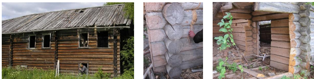
Рис. 1 – Крестьянский дом постройки 19 века в процессе обследования и сбора образцов ретродревесины
