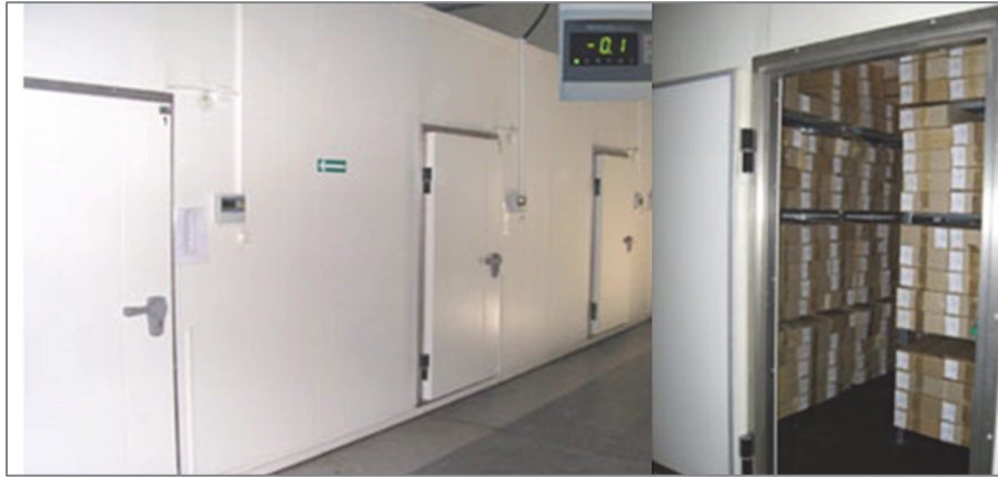
Рис. 5.4. Холодильная камера SL 14C35 «Финнебэкс» (Швеция)
