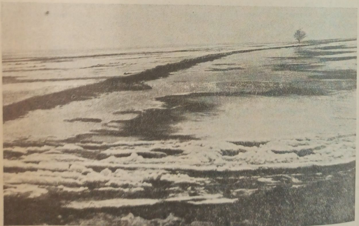
Рис. 2. Один из водозадерживающих валов, сооруженный на пахотном склоне для перехвата снеговой воды (Новосильская опытно-овражная станция, 1928 г.).
