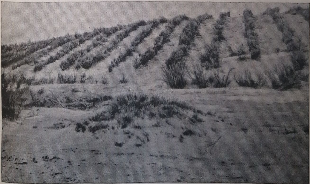
Рис. 7. Пески, укрепленные стоячими механическими защитами.
