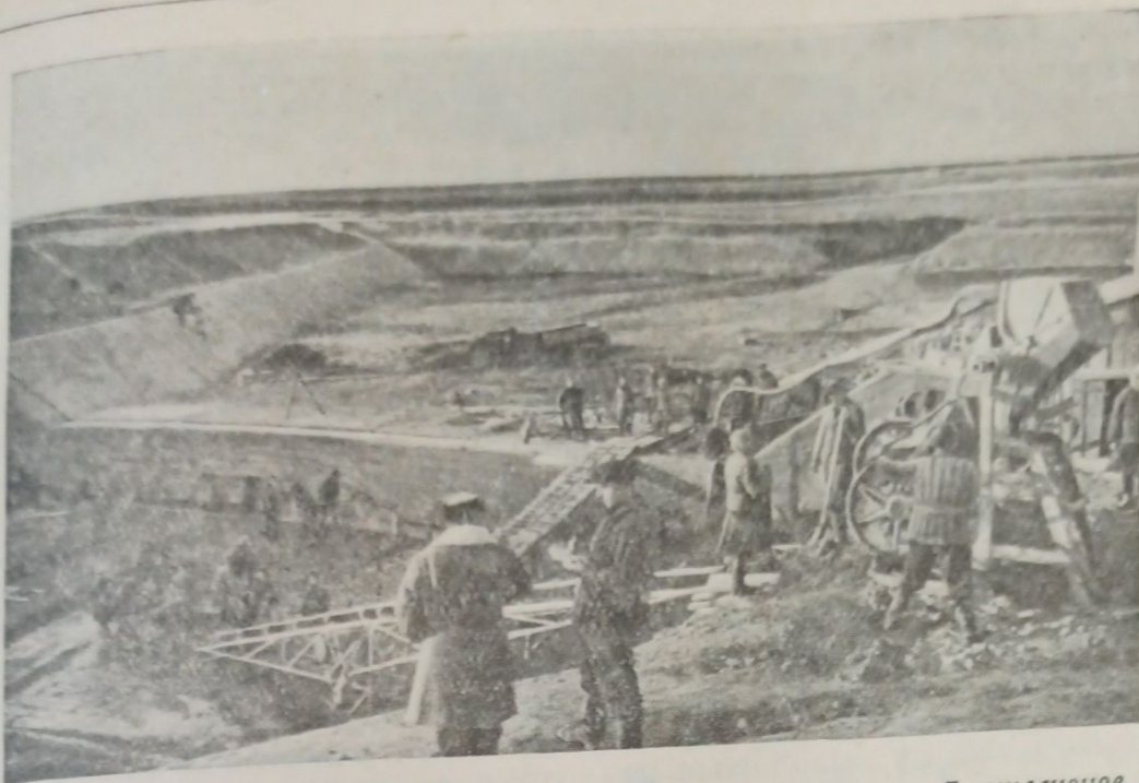
Строительство Сальского межколхозного водоема, емкостью 7 миллионов кубометров воды с зеркальной поверхностью 23 тысячи гектаров.
