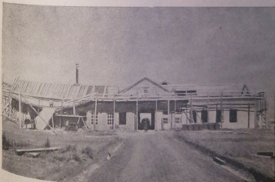
Строительство гаража в Уральской ЛЗС. Фото В. Степаненко (Фотохроника ТАСС)
