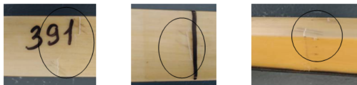
Рис. 8. Дефекты после испытания на циклические нагружения
