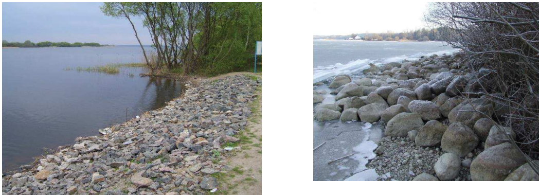
Рисунок 1 – Крепление откоса камнем
