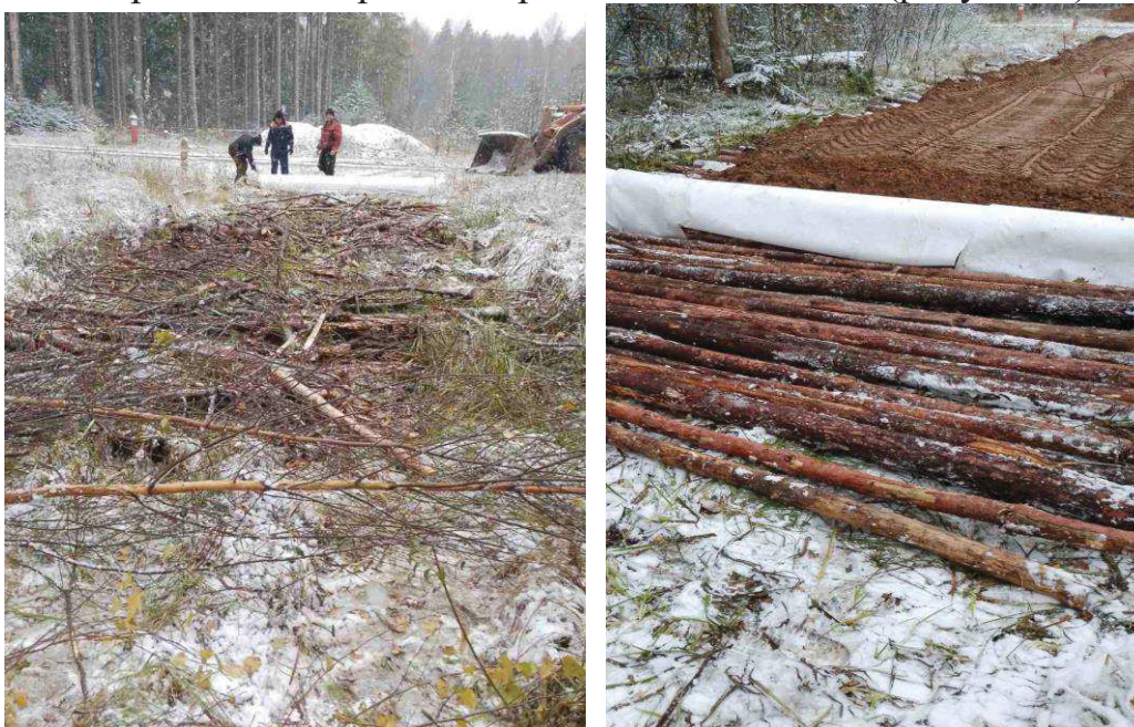
Рисунок 1 – Укладка комбинированной прослойки
