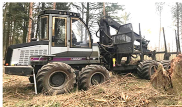
Рис. 7. Упрочнение поверхности грунтового основания хворостяной выстилкой
