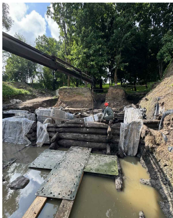
Рис. 2. Процесс разборки деревянных конструкций
