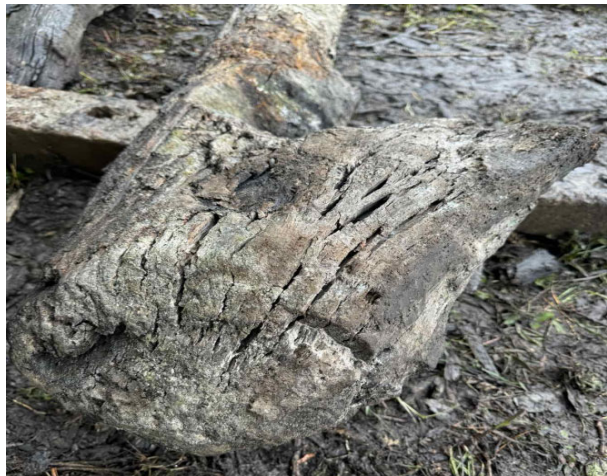
Рис. 6. Гаковая часть конструкции до гидромеханической очистки
