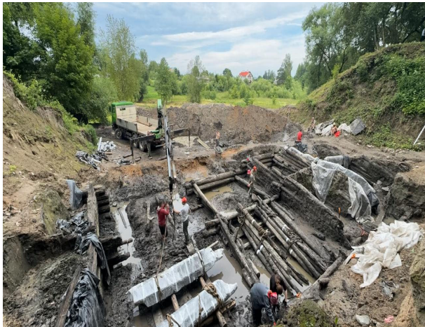
Рис. 4. Разборка конструкций и подготовка гидропакетов
