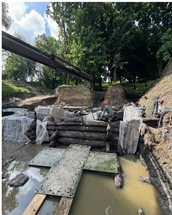
Рис. 2. Процесс разборки деревянных конструкций
