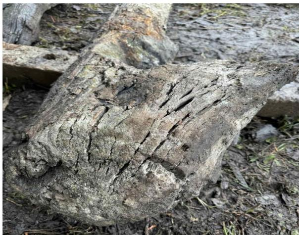
Рис. 6. Гаковая часть конструкции до гидромеханической очистки
