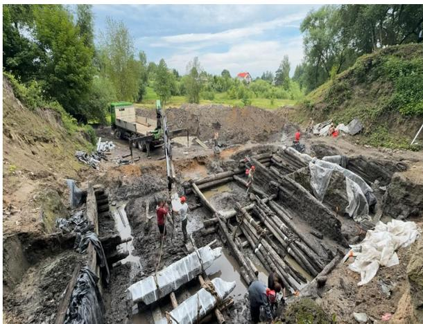
Рис. 4. Разборка конструкций и подготовка гидропакетов
