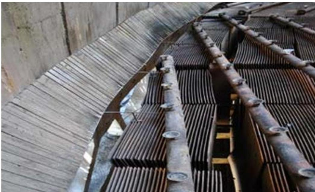
**Рисунок 1 – Оросительное и водораспределительное устройства старой конструкции**
