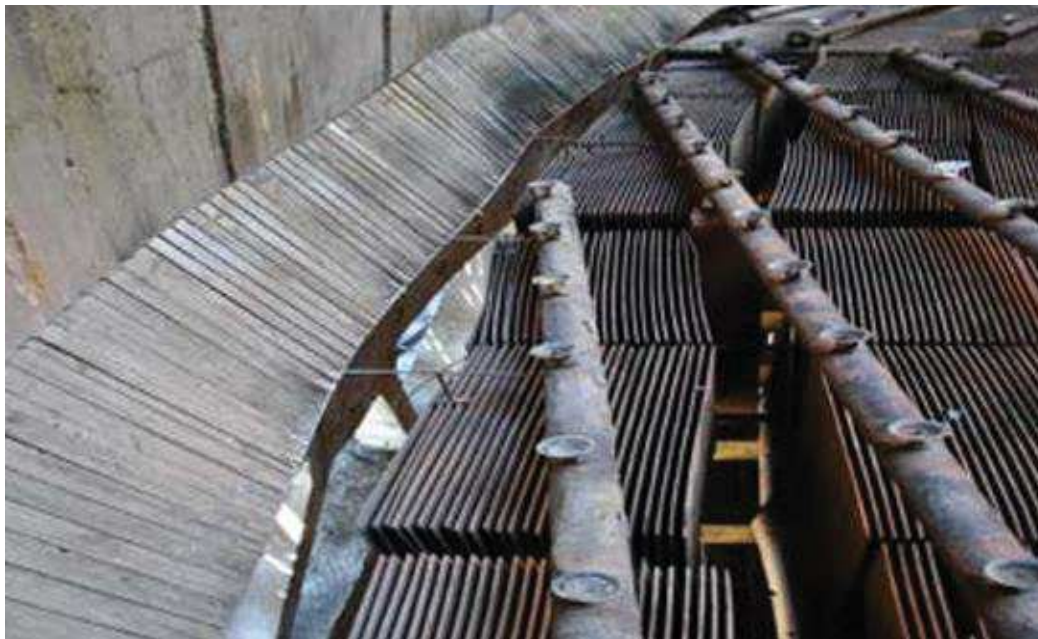
Рисунок 1 – Оросительное и водораспределительное устройства старой конструкции
