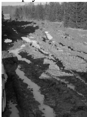
Рисунок 2 – Образование колеи на погрузочном пункте
